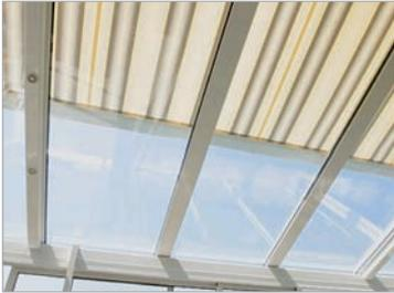
Aufdach- oder Unterdachmarkisen mit elektrischem Antrieb und Fernbedienung
