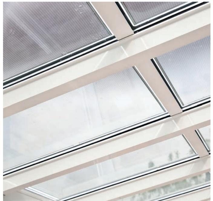
Semitransparente PV-Module montiert mit dem **PV 80 System -isoliert-**
