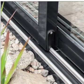
Leichtgängiges Schieben durch hochwertige Edelstahlschienen und Spezial-Kunststofflaufrollen
